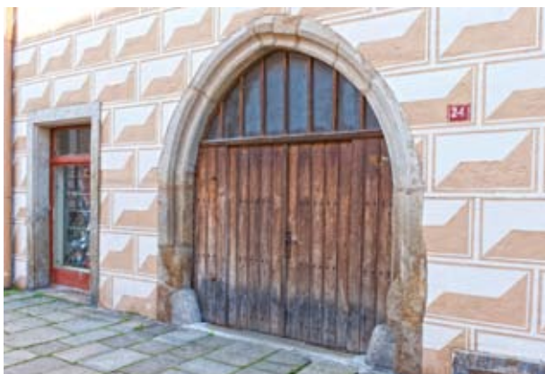
Gotický portál domu č. 24
