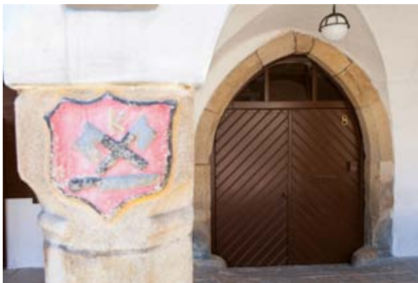
Gotický portál domu č. 8
