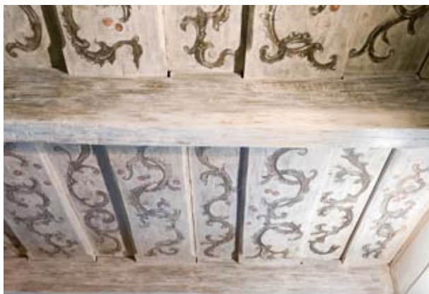
Dřevěný trámový malovaný strop - renesanční, v domě č. 31
