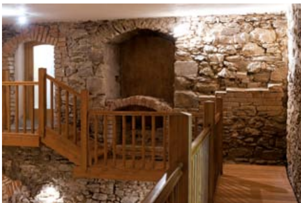
Detail ze sklepních prostor domu
